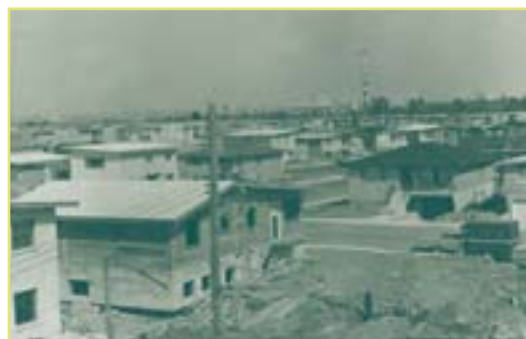
En 1963, tout est à faire dans le Domaine ! Les maisons sont en construction, les rues ne sont pas encore pavées et le terrassement des résidences n'est encore qu'un vague projet pour plusieurs résidents. Photo Collection famille Ernest Pilote
