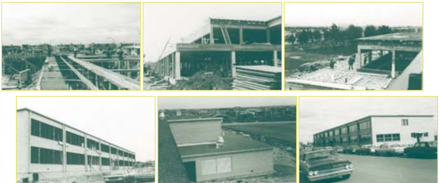
La construction de l'école Saint-Isaac-Jogues. Photos : Archives de la Commission scolaire de Montréal.
